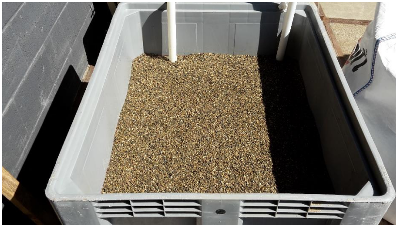
3) Vervolgens wordt een laag van 5 cm split 2/6 aangebracht.
