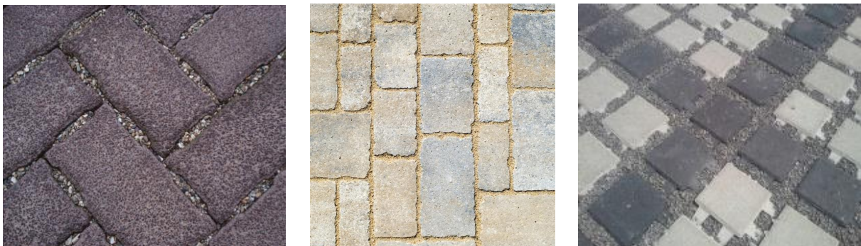
Figuur 4, 5 & 6: Voorbeelden van waterpasserende verhardingen (Bron: artstone.be ; klostermann-beton.nl & bleijko.be )
