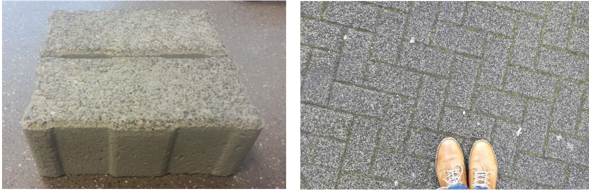
Figuur 13 & 14: Waterpasserende betonstraatsteen 'Rotterdam' (Bron: M.P.V. Laan; J. Advokaat )
