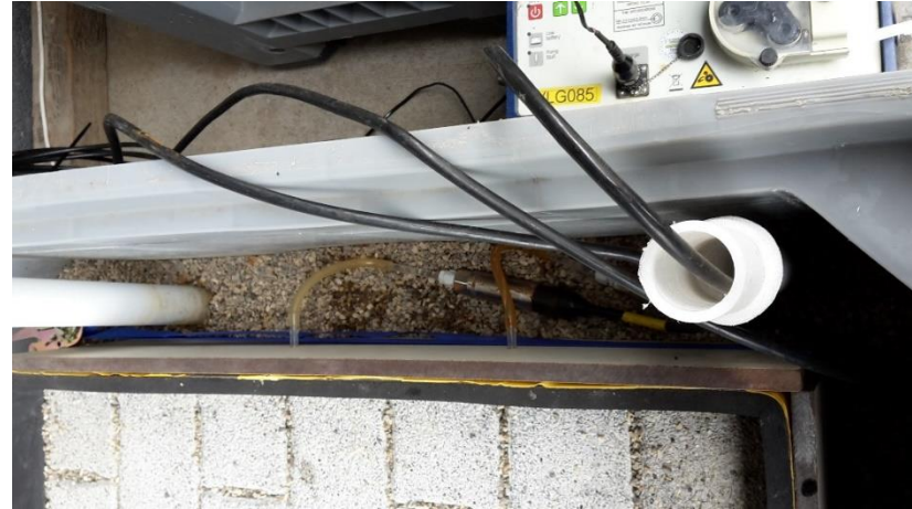
10) De druksensoren worden geplaatst in de peilbuizen (2) en in de voegen (2).
