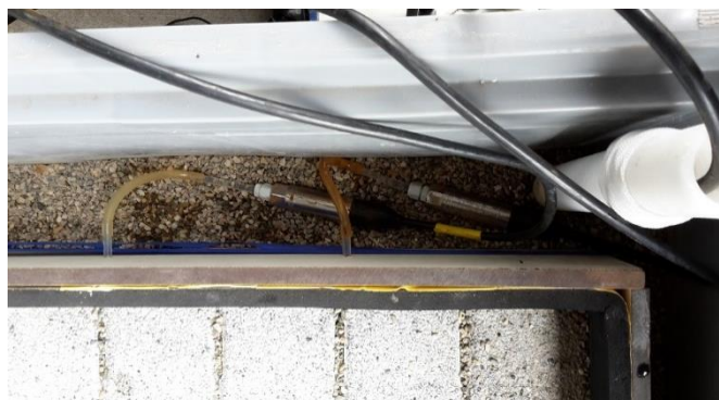
Figuur 2: De plaatsing van de druksensoren in de voegen
