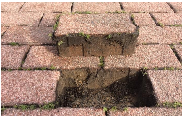
Dichtslibbing in de praktijksituatie
