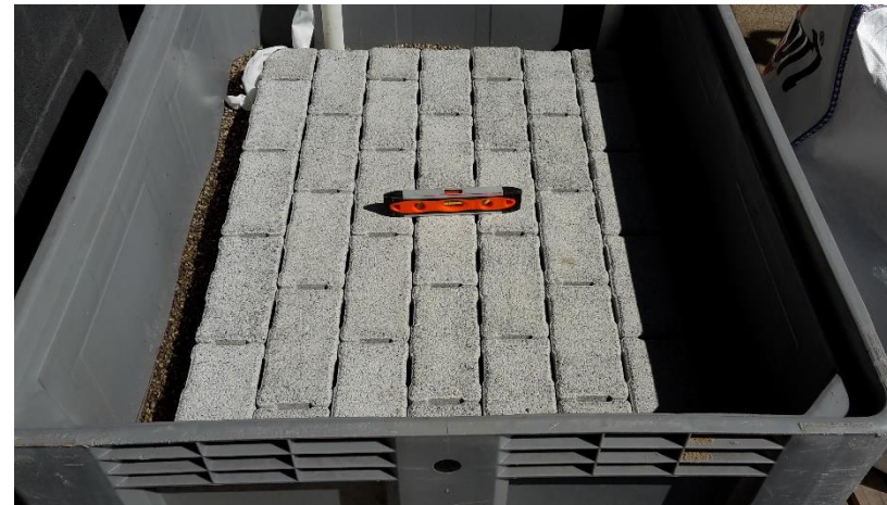
4) Hierop wordt de bestrating waterpas aangelegd.
