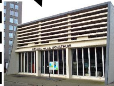
Aanpassing beheer afvoergemalen (voorbemalen, aanleg nieuwe gemalen)
