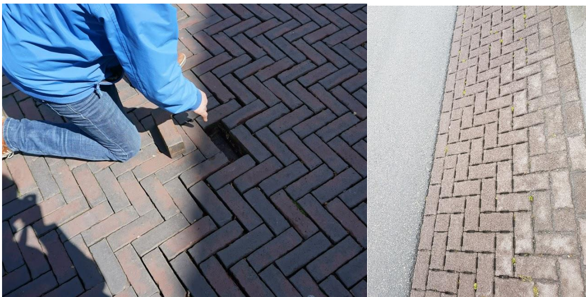
Figuur 2 (links) klapperende stenen (rechts) vervuiling zijkant van waterpasserende stenen
