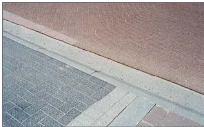
Figuur 1.10 Kantopsluiting tussen voetpad en rijbaan
