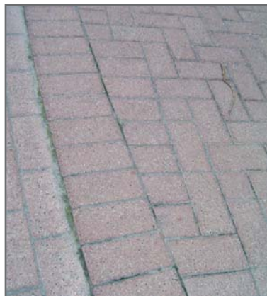
Figuur 4.13a Slechte uitvoering bij bocht (met te kleine stukken)
