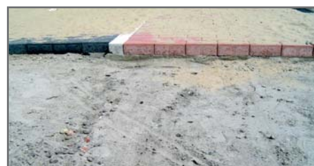
Figuur 1.4 Fundering met straatlaag, straatstenen en voegmateriaal
