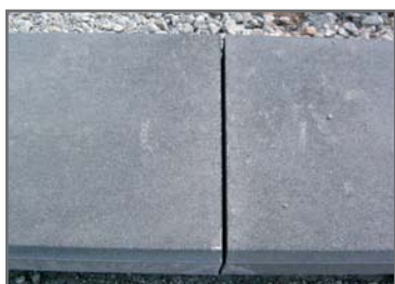
Figuur 4.3 Splintervrije kopse zijde van kantopsluiting
