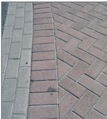
Figuur 4.13a Slechte uitvoering bij bocht (met te kleine stukken)
