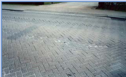
Figuur 1.7 Fijn materiaal aan oppervlak ten gevolge van pompen
