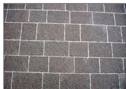
Figuur 1.8 Goede voegvulling voor opentelling voor verkeer
