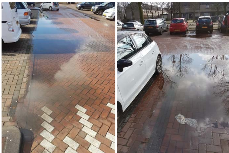
Figuur 3.1 Plasvorming Beverwijk 1 maart 2017. Links: parkeerplaats (zuidelijke gedeelte) gemeentehuis, rechts: parkeerplaats winkelcentrum Wijkerbaan
