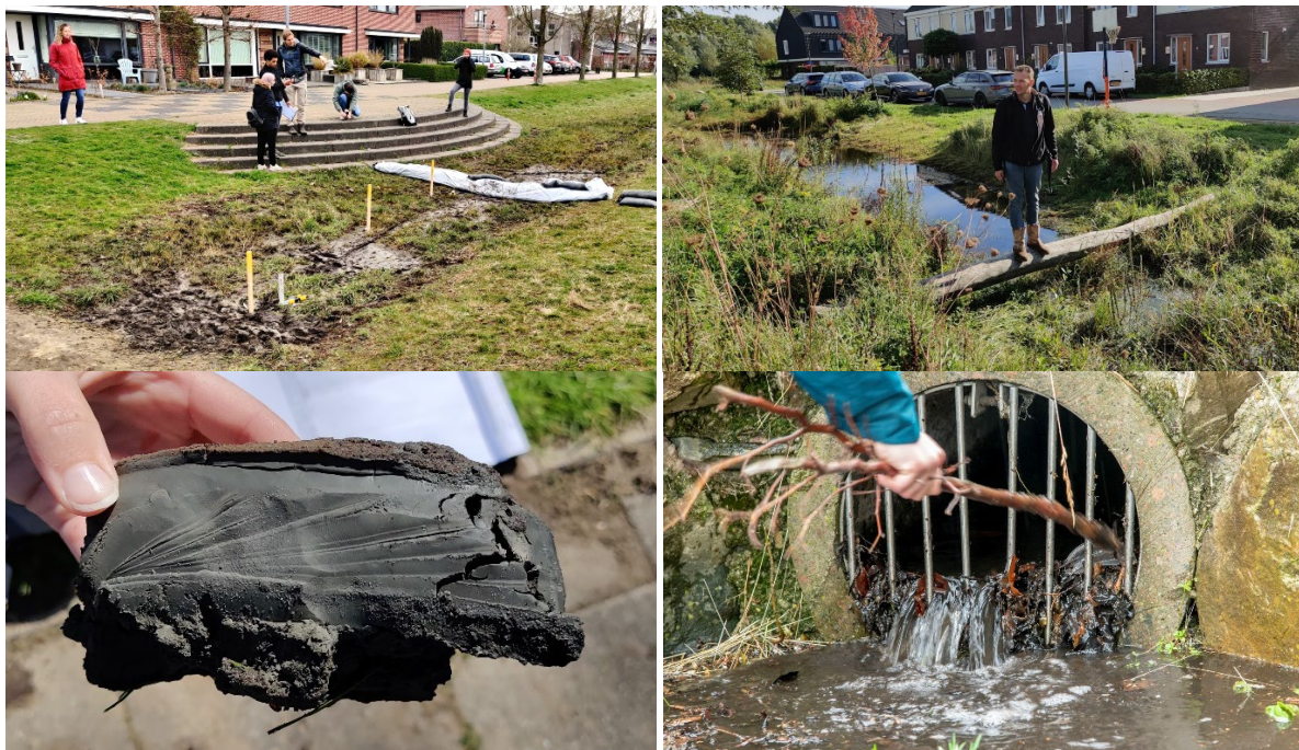
Figuur 30: Verschillende redenen waarom de infiltratie van wadi's niet goed werkte. Linksboven: wadi in Bergen, waar de bodem was dichtgeslibd. Rechtsboven is een wadi in Haren die door een aanlegfout eerder een sloot is. Linksonder een blok klei uit de bodem van een wadi in Rotterdam en rechtsonder een verstopte toevoer naar een wadi door gebrek aan onderhoud.
